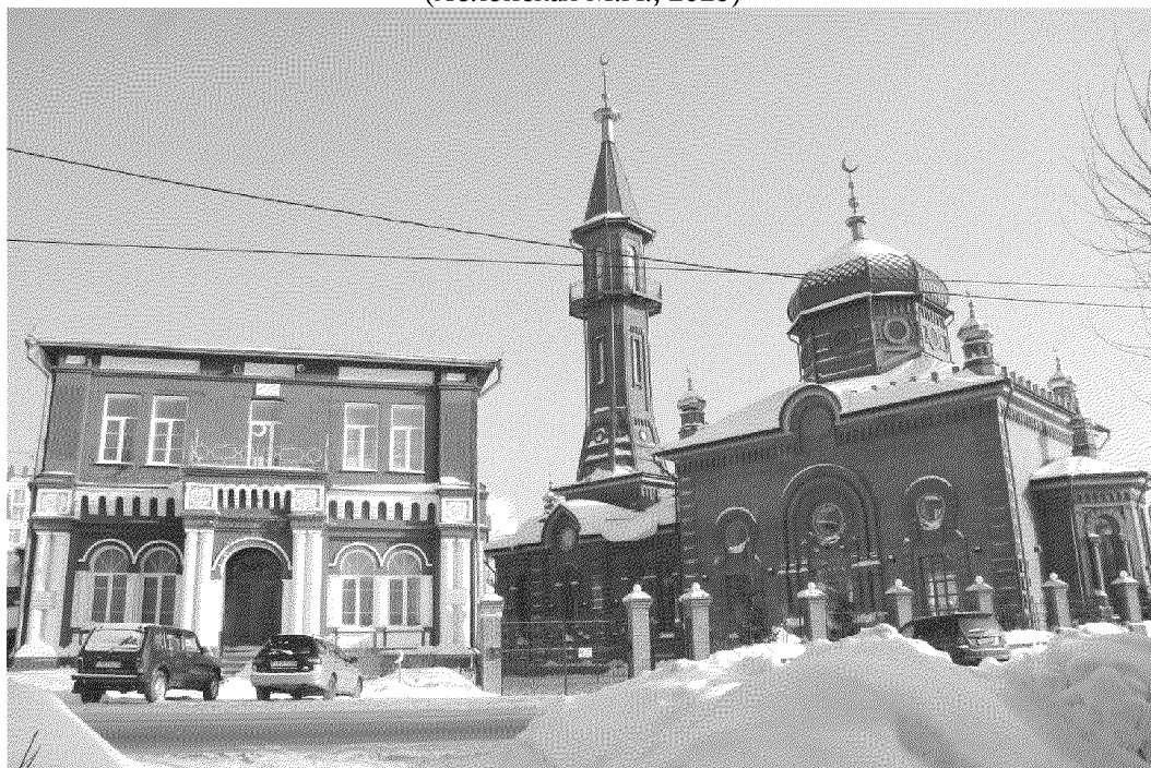
Видовая точка № 2 Общий вид ансамбля с западной стороны, с ул. Татарской (Яблонская М.А., 2025)
