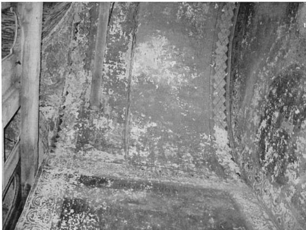
24. Алтарь церкви второго яруса. Орнаментальная живопись на своде и подпрудной арке
