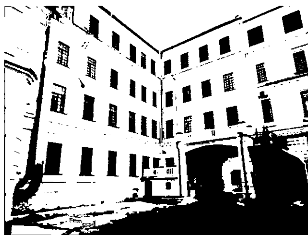
Вид на корпус 1, литера Б (северный и восточный дворовый фасад) и корпус 2, литера Б (восточный фасад)
