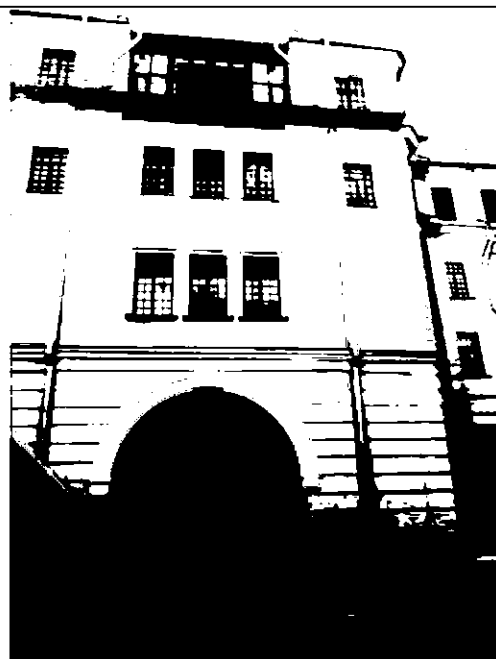
корпус 1, литера Б (северный дворовый фасад)
