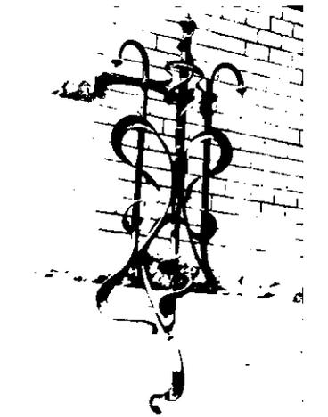
решетки (2) оконных проемов бывшей привратничкой – из вертикальных прутков разной длины, выгнутые над подоконным отливом, внизу скрепленные на металлической планке с фигурными завершениями.
